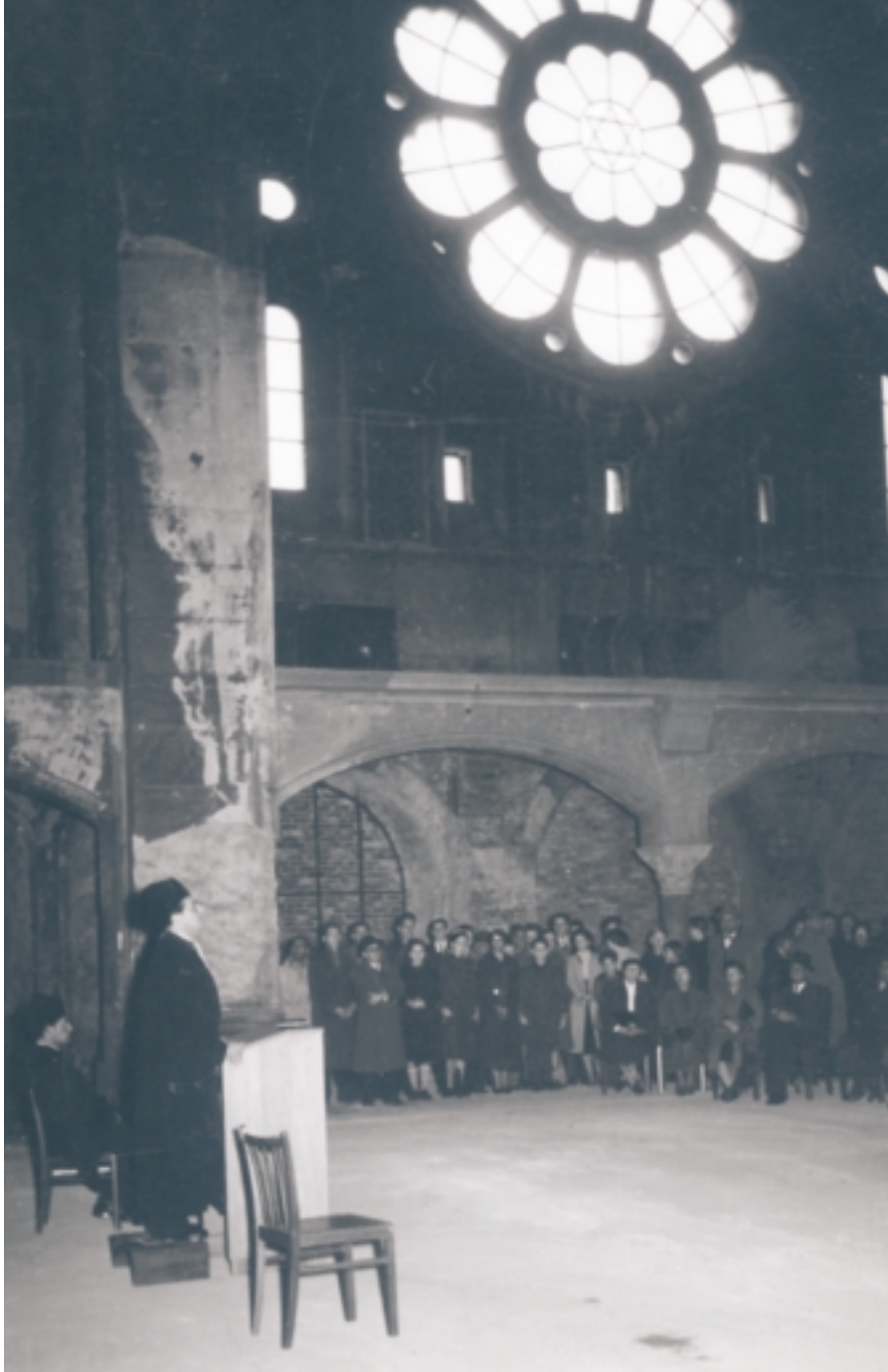
Gedenken des 9. Novembers 1938 in der Ruine der Synagogengemeinde Roonstraße am 9. November 1955
